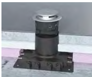
Τοποθέτηση σε δάπεδο από μπετόν
